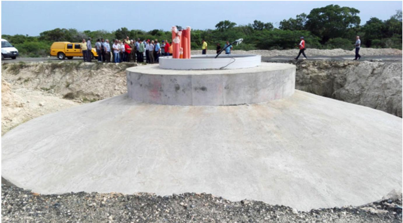
Las Tunas.- Tres de las 34 bases para colocar los aerogeneradores del Parque eólico La Herradura-1, en el norte de Las Tunas, terminaron de construirse, para lo cual fue necesario que trabajadores de la Empresa de Construcción y Montaje tuvieran que laborar 12 horas ininterrumpidas en cada una.
