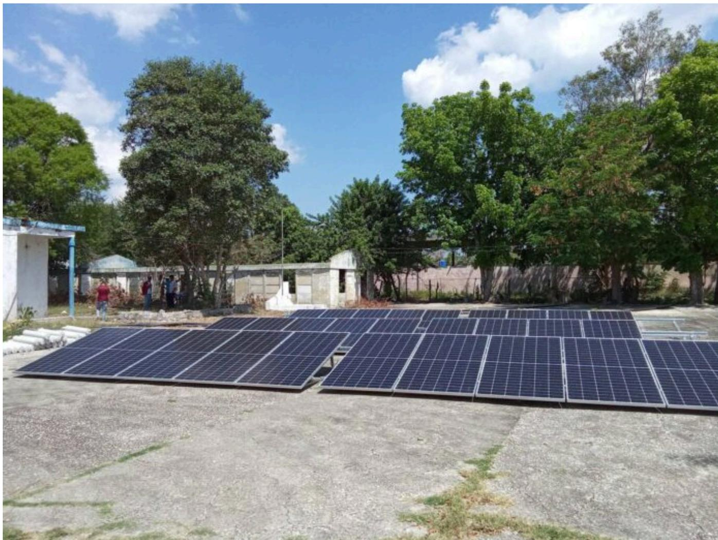
**Concluye Las Tunas cambio de matriz energética en estaciones de bombeo de agua.** Con la instalación de paneles solares y bombas sumergibles, en 142 estaciones, Las Tunas se convirtió en la primera provincia del país en concluir el cambio de matriz energética para el bombeo de agua potable.
